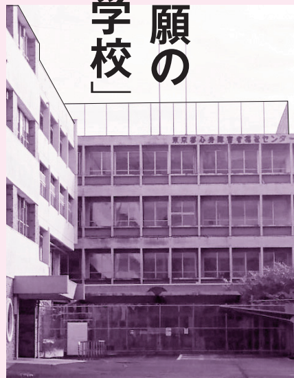
解体が始まる旧都立障害者センター
